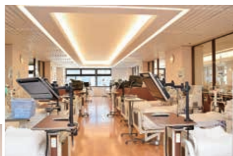
天井に放射空調パネルを設置した透析室
