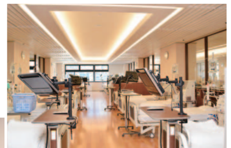
天井に放射空調パネルを設置した透析室
